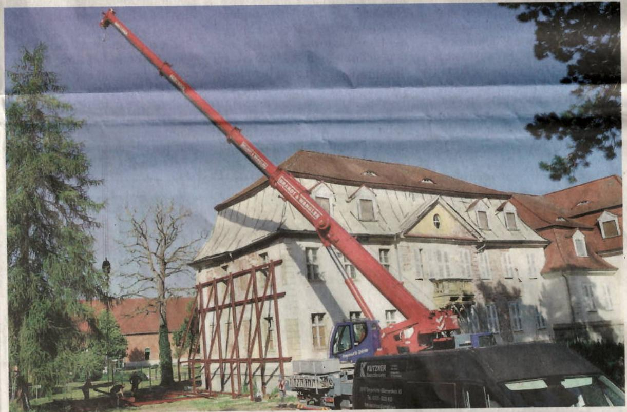
Ein Mobilkran stellt am Südgiebel des Herrenhauses eine stählerne Stützkonstruktion auf. Erst nach umfangreichen statischen Sicherungsarbeiten kann das Dach aufgenommen werden. FOTO: THOMAS LINBNER
